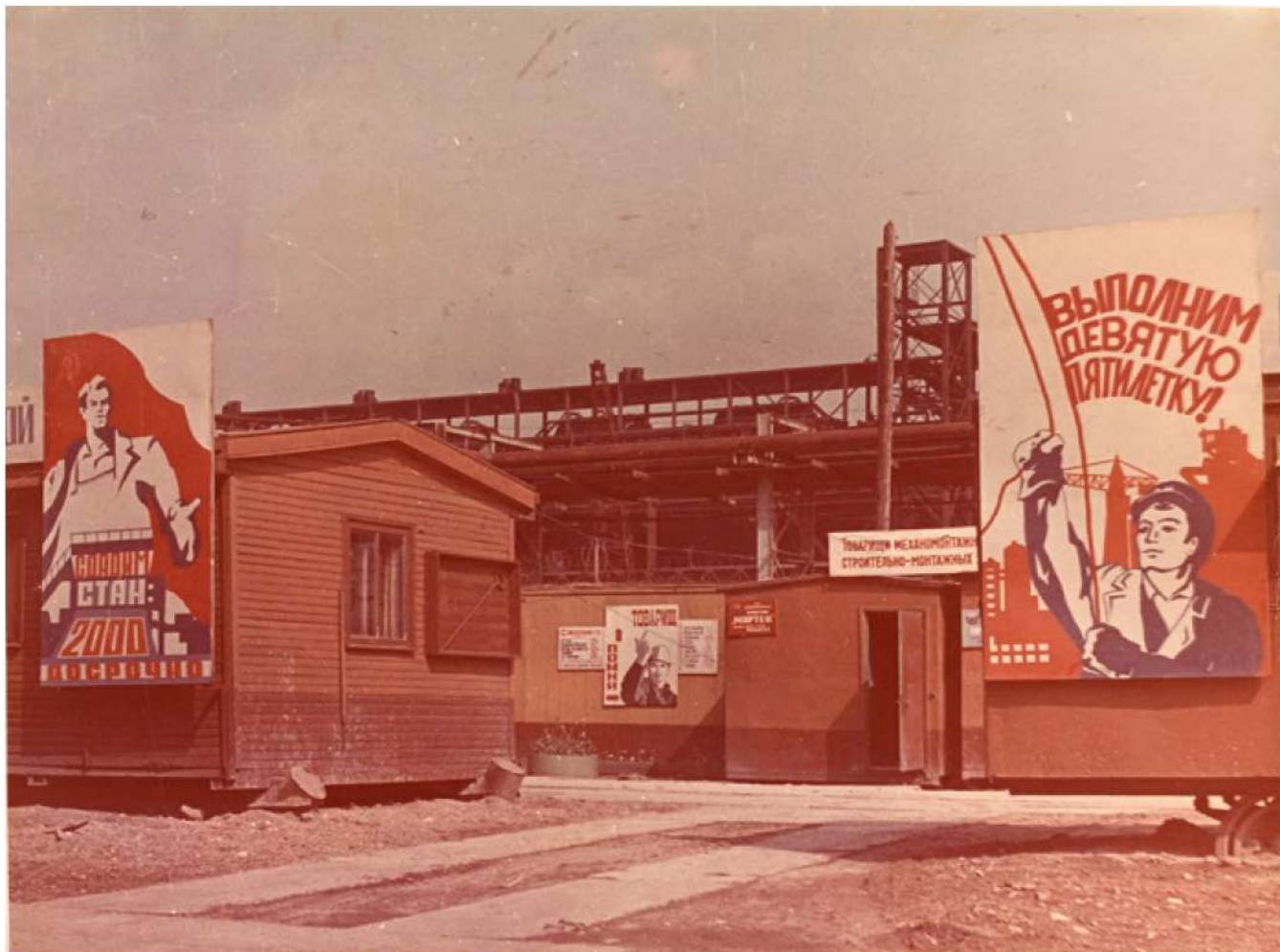
Неизвестный автор. Агитационные транспаранты и стенды у входа на территорию строительного участка «Мартен» Череповецкого металлургического завода. Череповец. 1974. Цветной фотоотпечаток. 40 × 29. ВОАНПИ. Ф. Р-9332. Оп. 8. Д. 121. © KAV BO «Вологодский областной архив новейшей политической истории»
