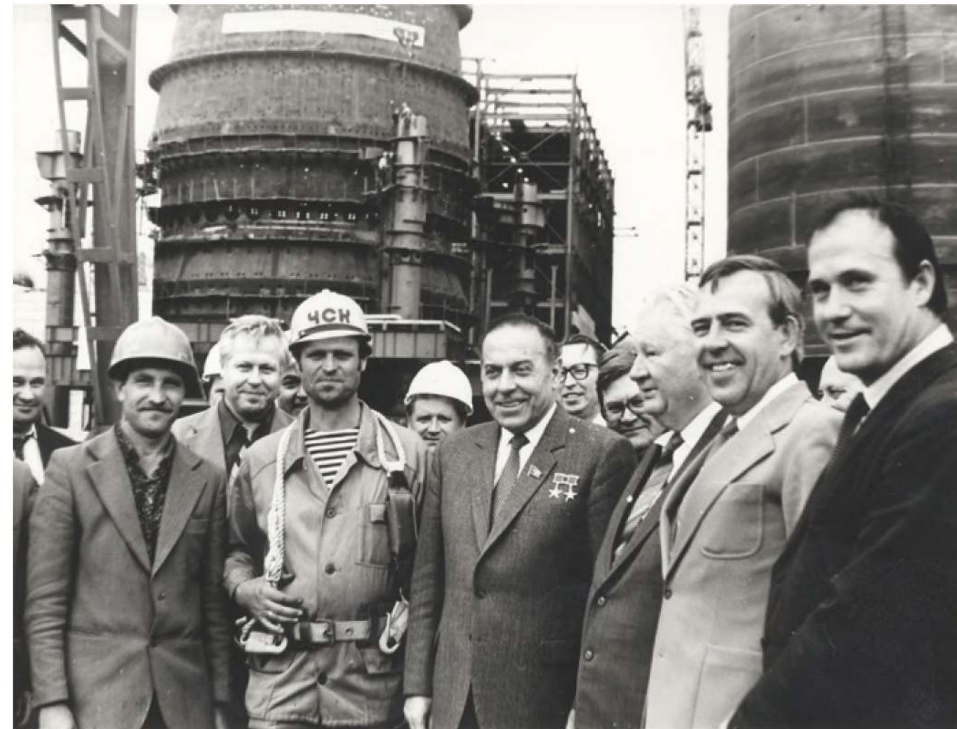
Неизвестный автор. Г. А. Алиев в группе работников Вологодского обкома КПСС, руководителей и рабочих Череповецкого металлургического комбината на строительной площадке доменной печи № 5 ЧМК. Череповец. 2 июля 1983.
